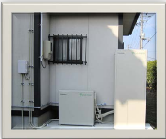
エネファーム設置（燃料電池） LPガスより水素を取出し発電し排熱を給湯で使用
