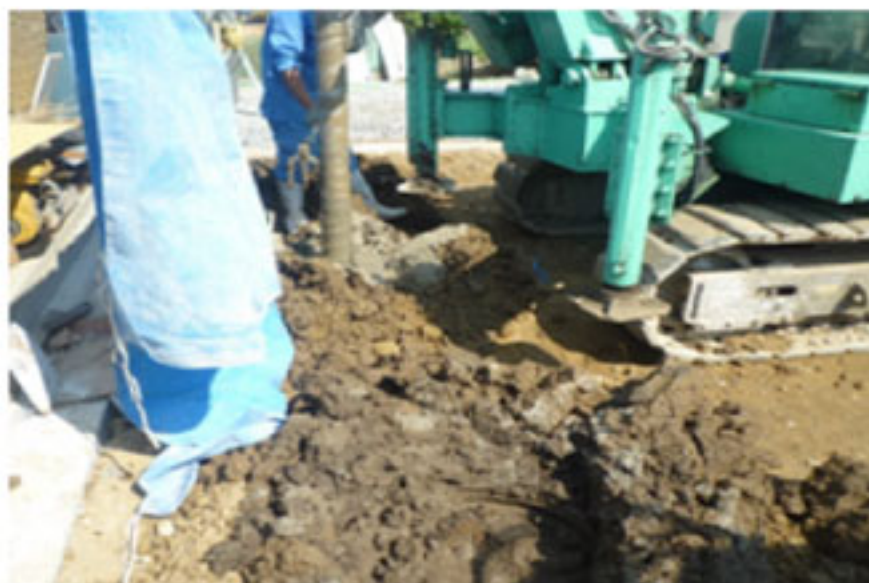
地盤改良工事
